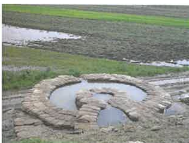
5. sz. képcsoportok: A buzgár kiépített ellennyomó medencéje
