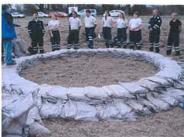
6. sz. képcsoportok: A buzgár ellennyomó medencéjének kiépítése
