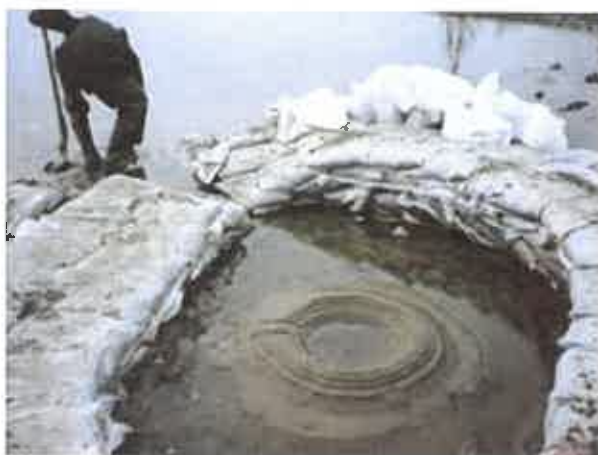
5. sz. képcsoportok: A buzgár kiépített ellennyomó medencéje
