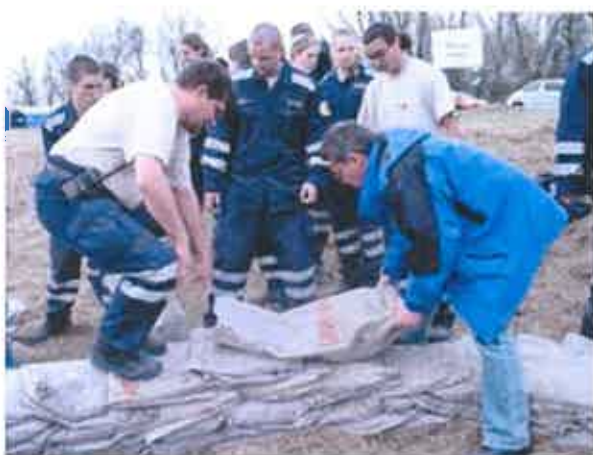
6. sz. képcsoportok: A buzgár ellennyomó medencéjének kiépítése
