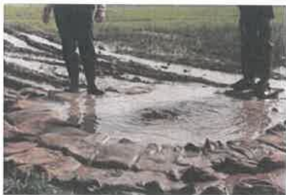
3. sz. kép: Buzgár közvetlenül a felfedezése után
