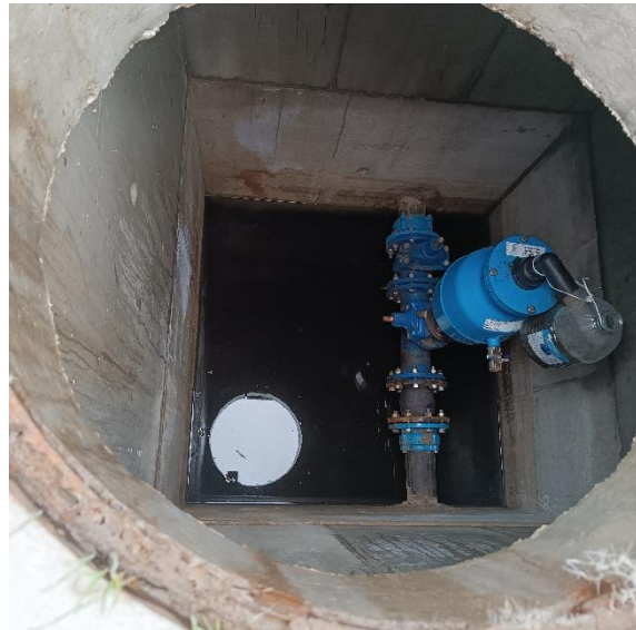
5. kép: Légtelenítő akna gépészeti szerelvények
