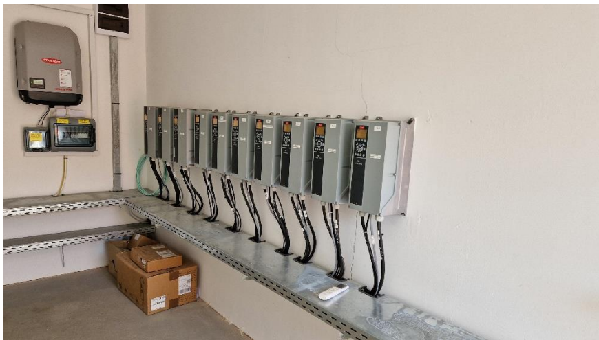
19. kép: Villamos kapcsoló helyiség Frekvencia váltók
