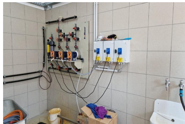
14. kép: Vegyszer adagoló szivattyúk
