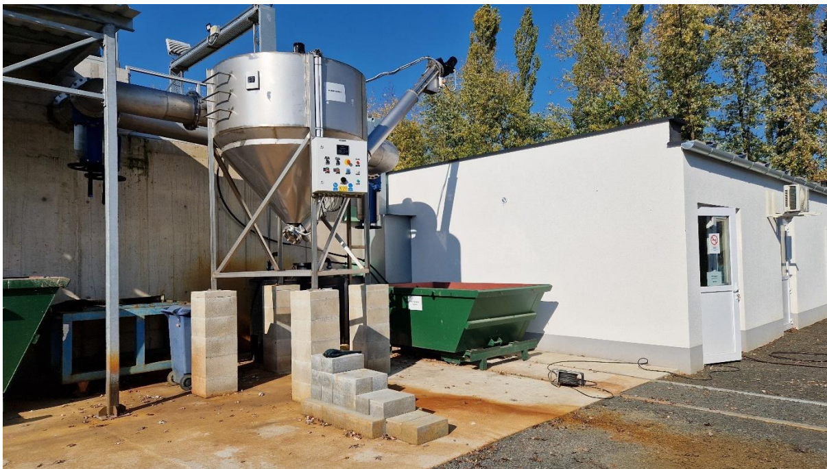
10. kép: Homokfogó berendezés
