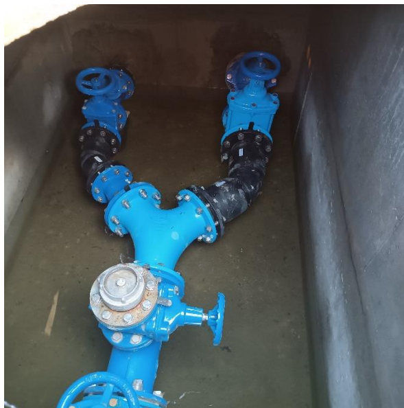
3. kép: Gépészeti szerelvények (nadrágidom)
