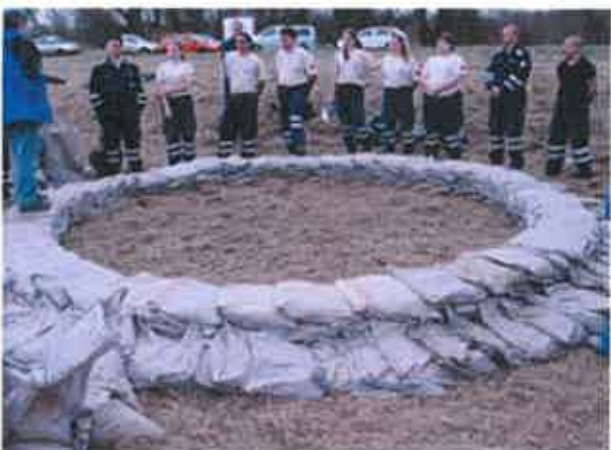
6. sz. képcsoportok: A buzgár ellennyomó medencéjének kiépítése
