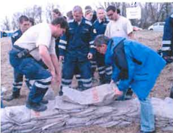
6. sz. képcsoportok: A buzgár ellennyomó medencéjének kiépítése
