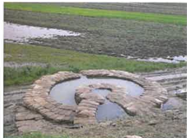
5. sz. képcsoportok: A buzgár kiépített ellennyomó medencéje
