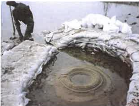
5. sz. képcsoportok: A buzgár kiépített ellennyomó medencéje
